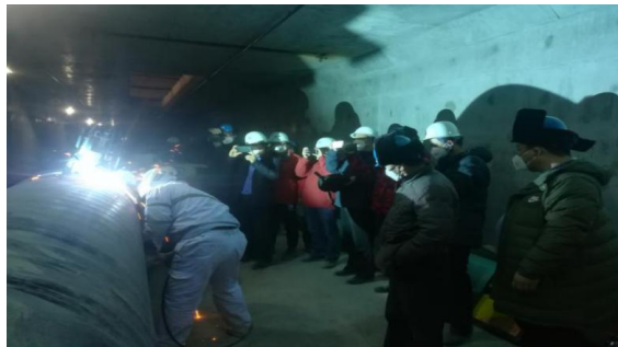
图7 北京城市副中心地下管廊给水管道的自动焊接
