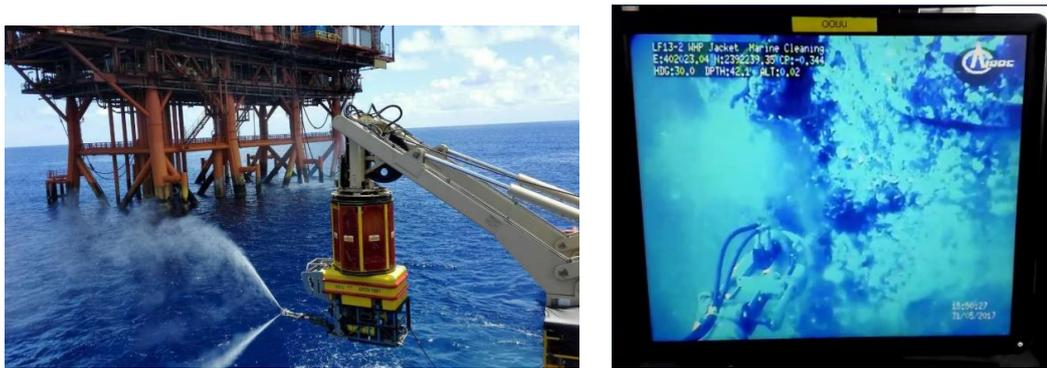
图 2 基于 ROV 的平台导管架水下高效海生物清理系统
